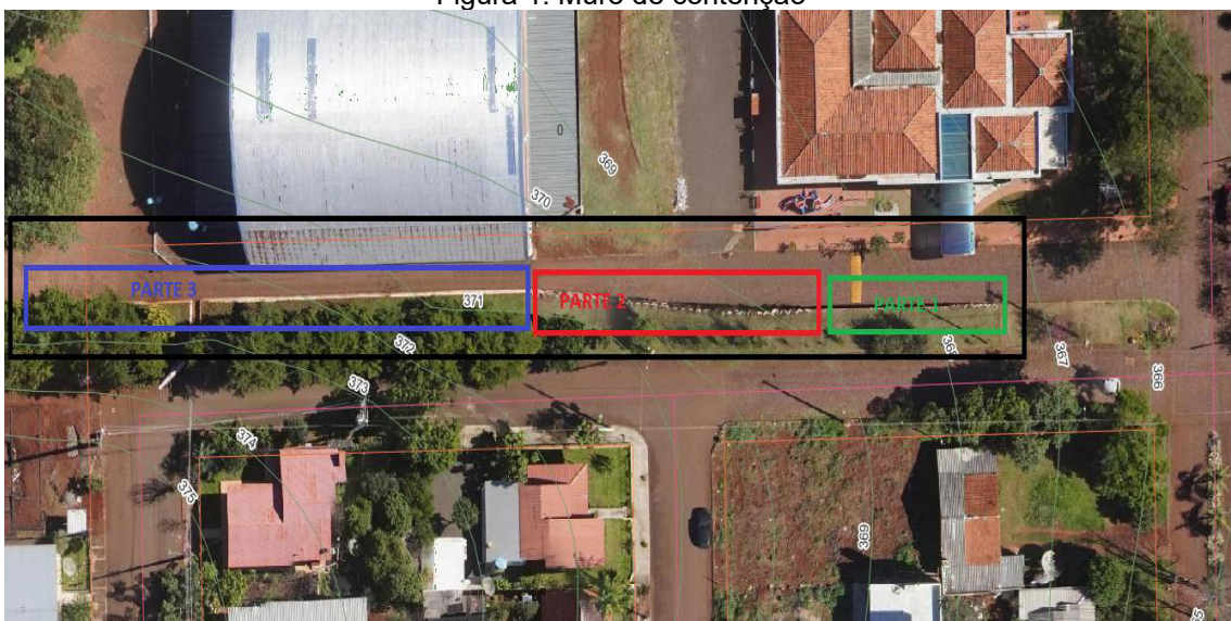
Figura 1: Muro de contenção
