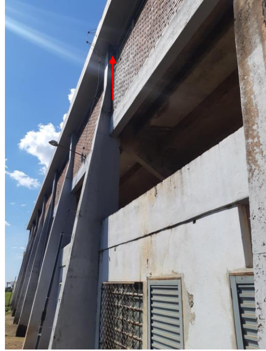
Imagem 07: Lateral oeste onde será instalado os tubos de queda.
