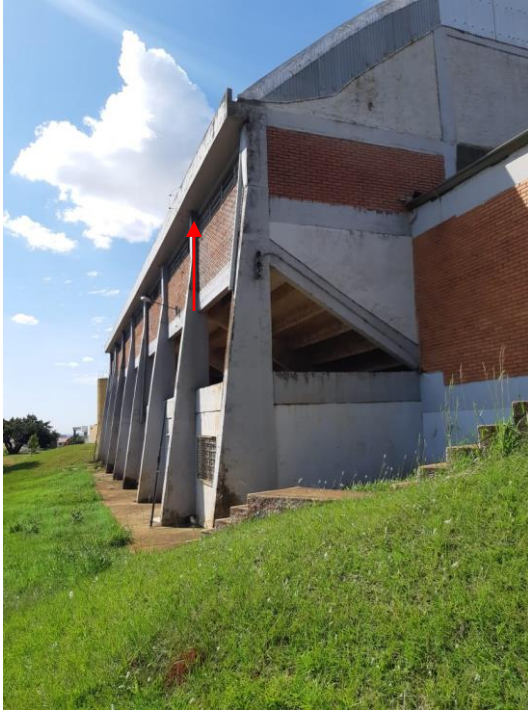
Imagem 06: Lateral oeste onde será instalado os tubos de queda.
