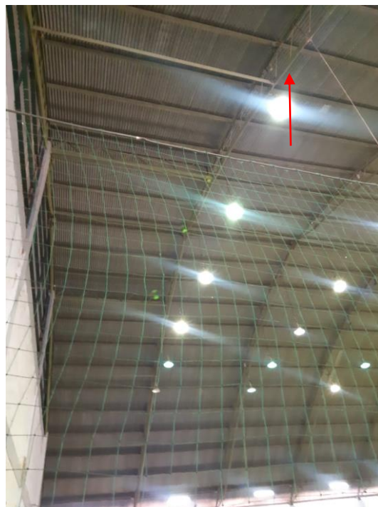
Imagem 05: Vista das tesouras existentes, local a ser fixada as terças.
