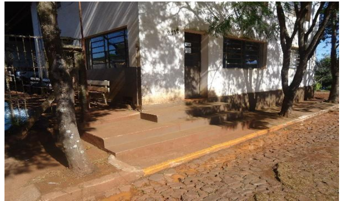
Prédio 1 – Acesso de pedestres existente
