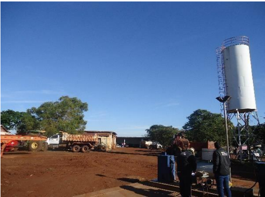
Visual da pista de abastecimento para oeste, com reservatório existente a direita.
