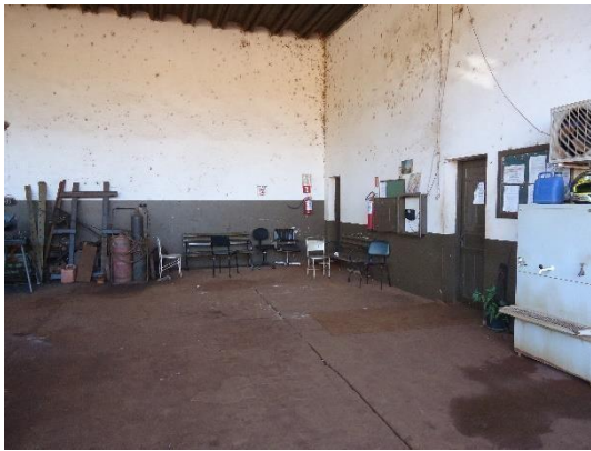
Prédio 3 – piso a reformar
