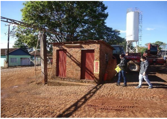
Prédio 4 - a Reformar
