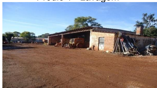
Garagem existente – a demolir
